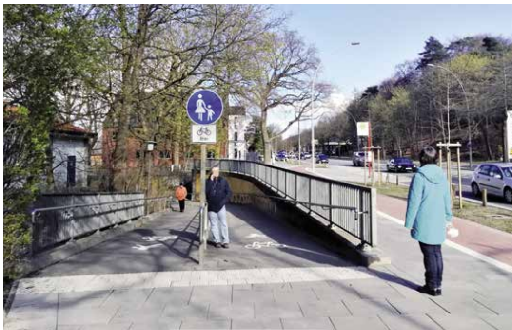
Ein echtes Ärgernis: Diese Fußgängerunterführung unter der Cuxhavener Straße/B 73 bei der Bushaltestelle Hausbruch muss gleichzeitig als Teil der Veloroute 10 erhalten.
