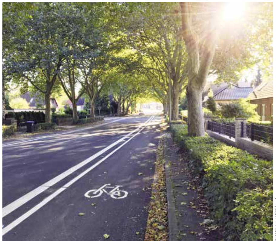
Mit dem Radfahrstreifen am Leeschenblick hat die Bezirksgruppe Wandsbek eine bessere Lösung als die ursprünglich geplanten schmalen Schutzstreifen erreicht.
